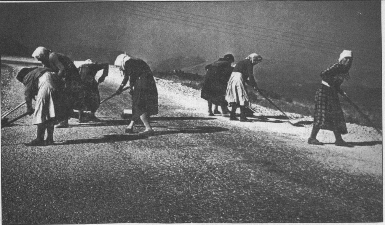
Κατασκευή δρόμου. Σπ. Μελετιῆς: «Θεσπρωτία».
